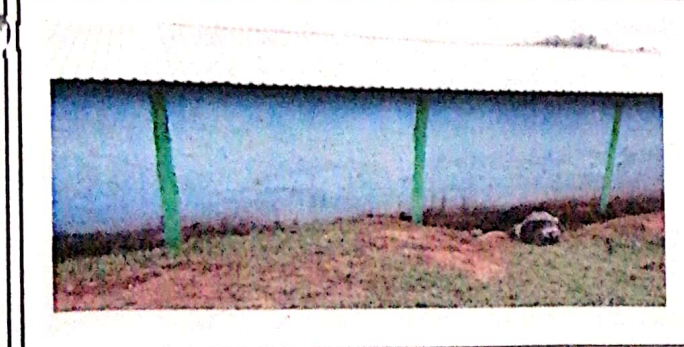
Foto 5: Cubierta de lamina de cocina
