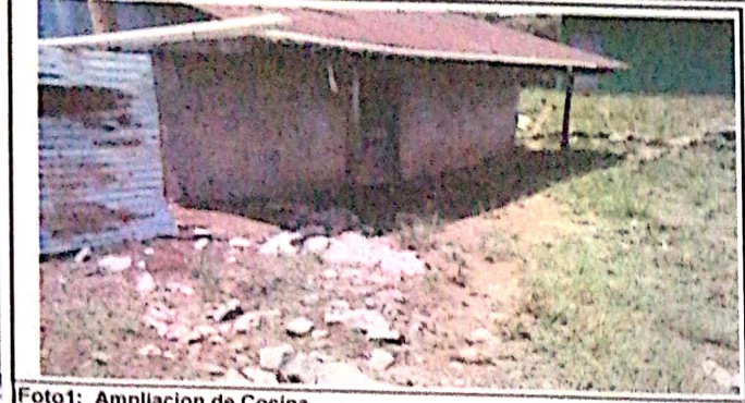
Foto 1: Ampliación de Cocina
