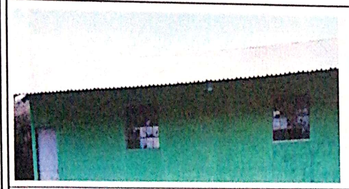
Foto 3: Ampliacion de Ventanas
