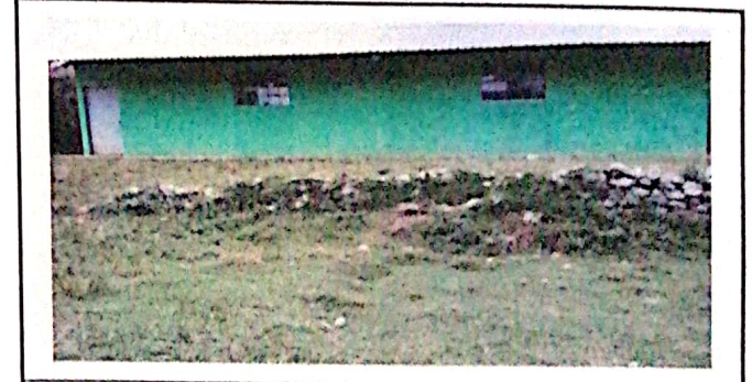
Foto 6: Ampliacion de Corredor
