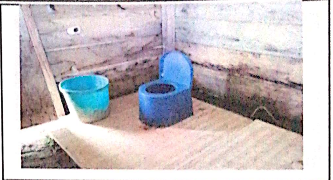
Foto 2: Sustitucion de Servicio Sanitario
